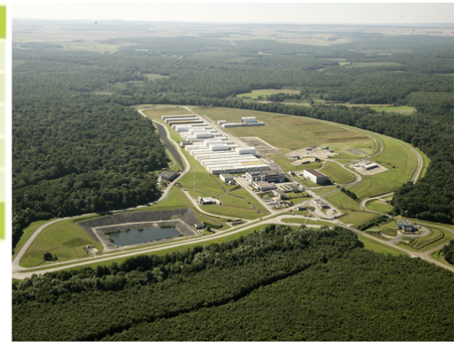
Centre de stockage de l'Aube
