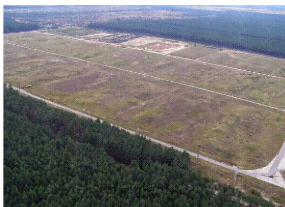
Figure 4 : Vue du site de stockage de Buriakovka
