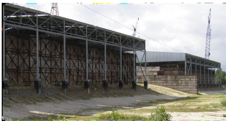
Figure 5 : Vue du site d'entreposage de Podlesny
